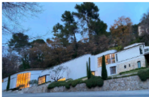
Vue de l'extérieur de la Fondation CAB à Saint-Paul de Vence. © D.R.
