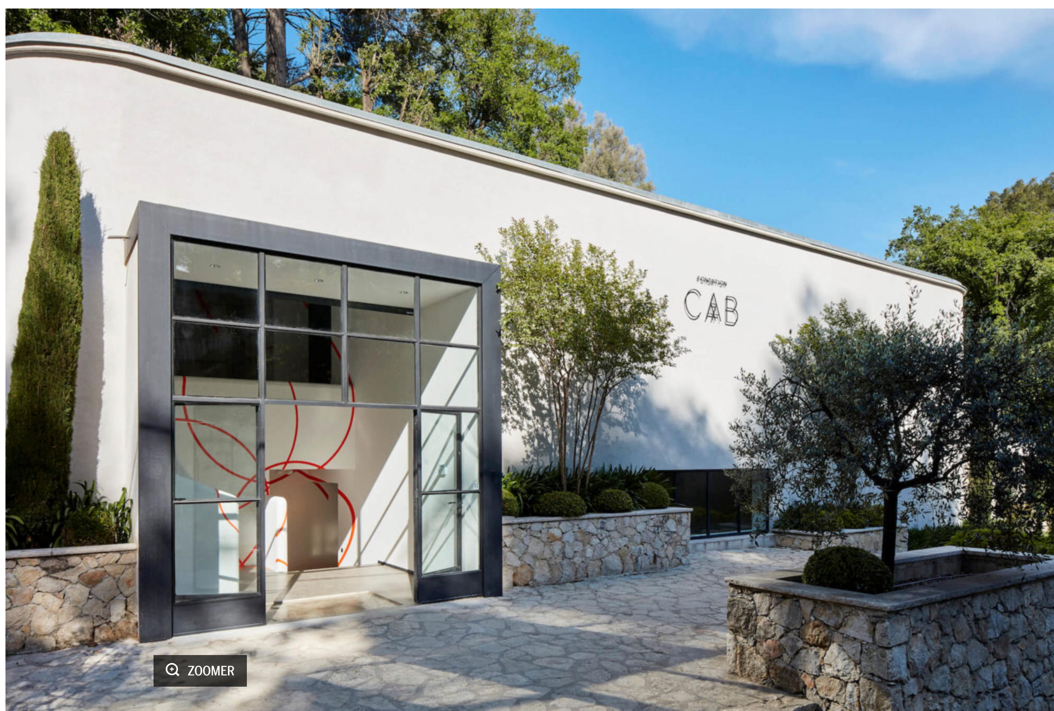
La Fondation CAB, à Saint-Paul-de-Vence
